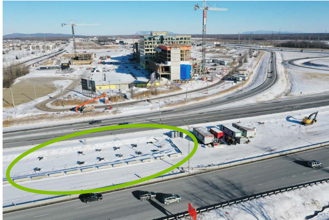
Travaux de fondations de la station Du Quartier
